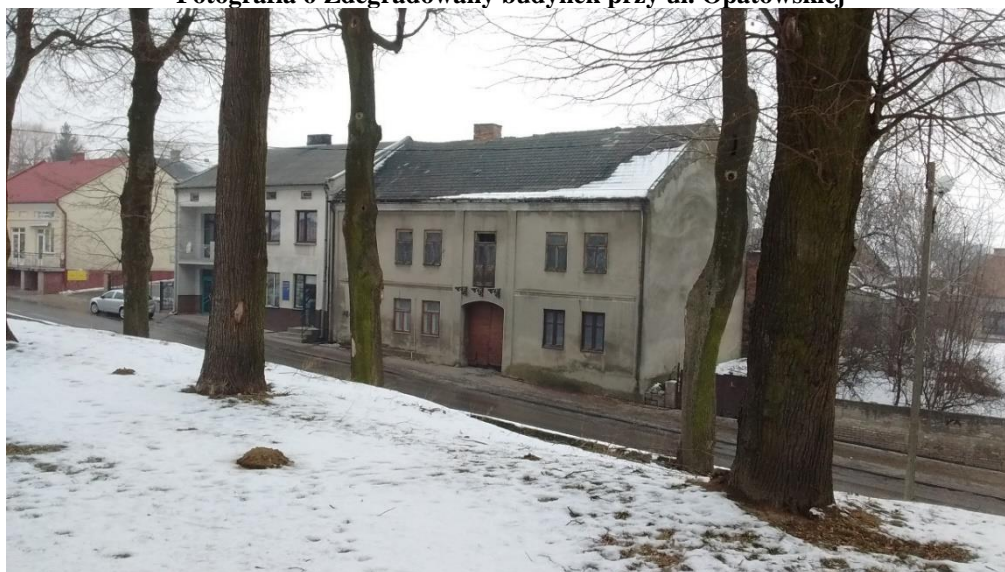
Fotografia 6 Zdegradowany budynek przy ul. Opatowskiej
