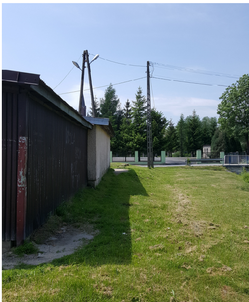
Widok południowo - zachodni
