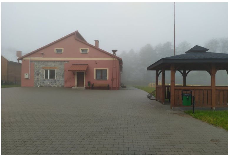
Świetlica Wiejska w Łopatnie
